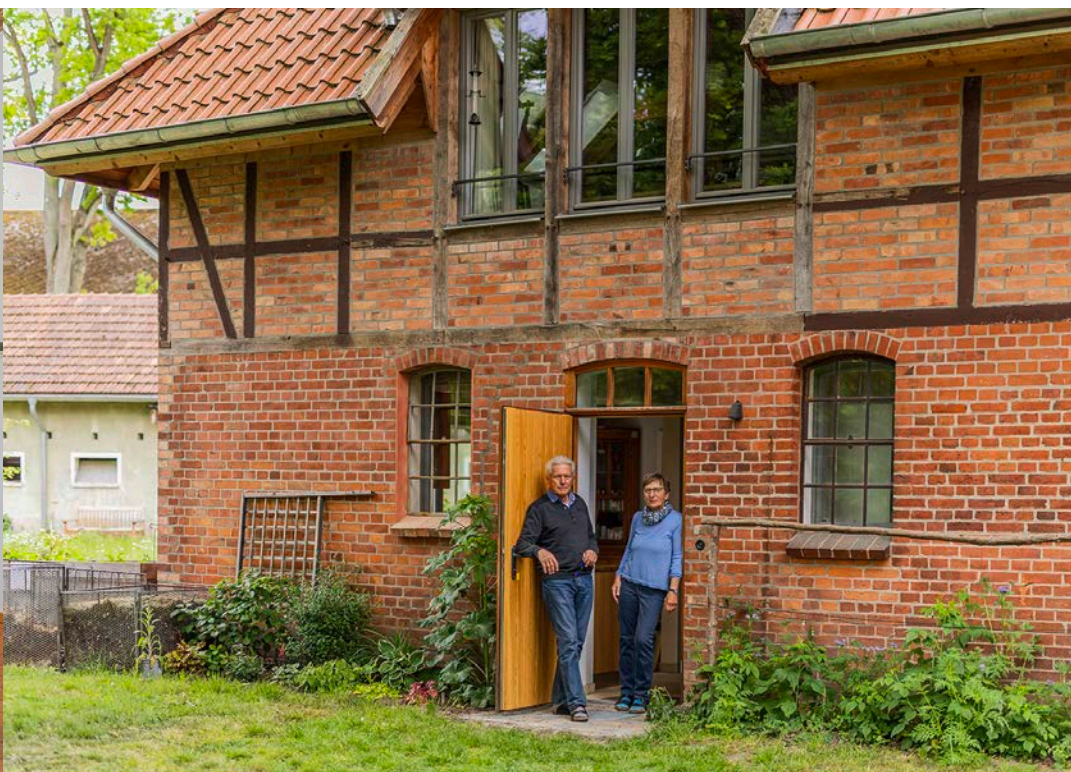
Rudolf und Regina vor ihrer Wohnung. Die Stallfenster sind mit Isolierglasfenstern aufgedoppelt.
