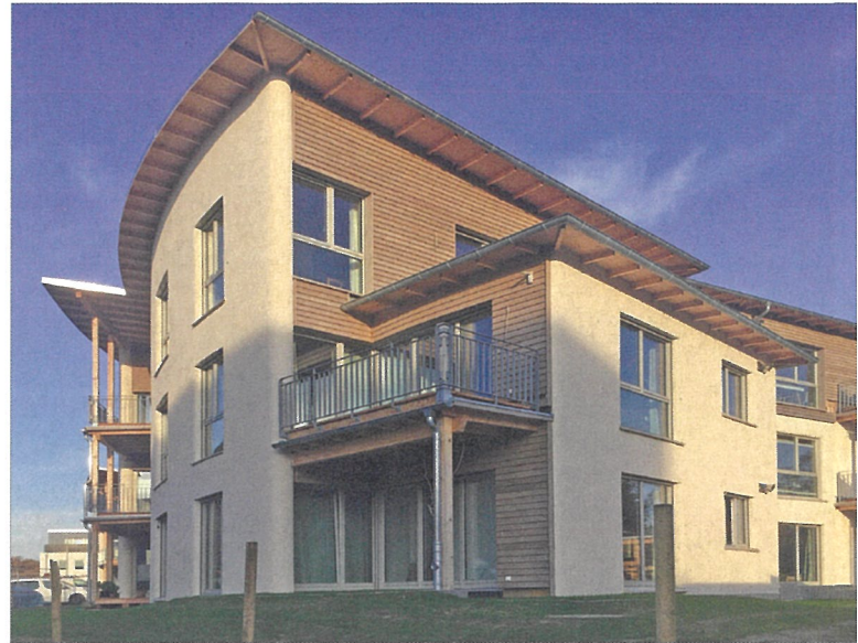
Die 19 Wohneinheiten sind aus schadstofffreiem und kreislauffähigem Holz, Stroh, Kalk, Lehm und Zellulose. Bild: Dirk Scharmer
